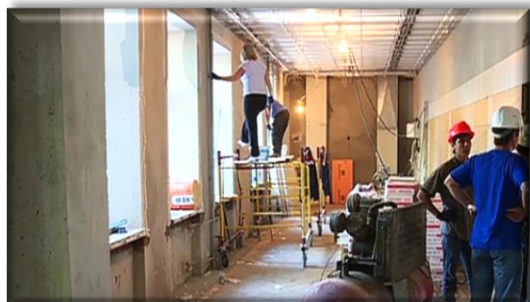
Обская библиотека - филиал Капитальный ремонт помещения
