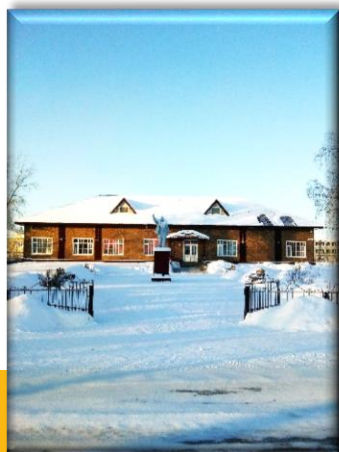
МКУК «Подгорнский ЦКиД» Капитальный ремонт крыльца
